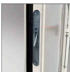
Contre serrure avec verrouillage haut et bas intégré dans semi-fixe et butée de sol (porte 2 vantaux).
